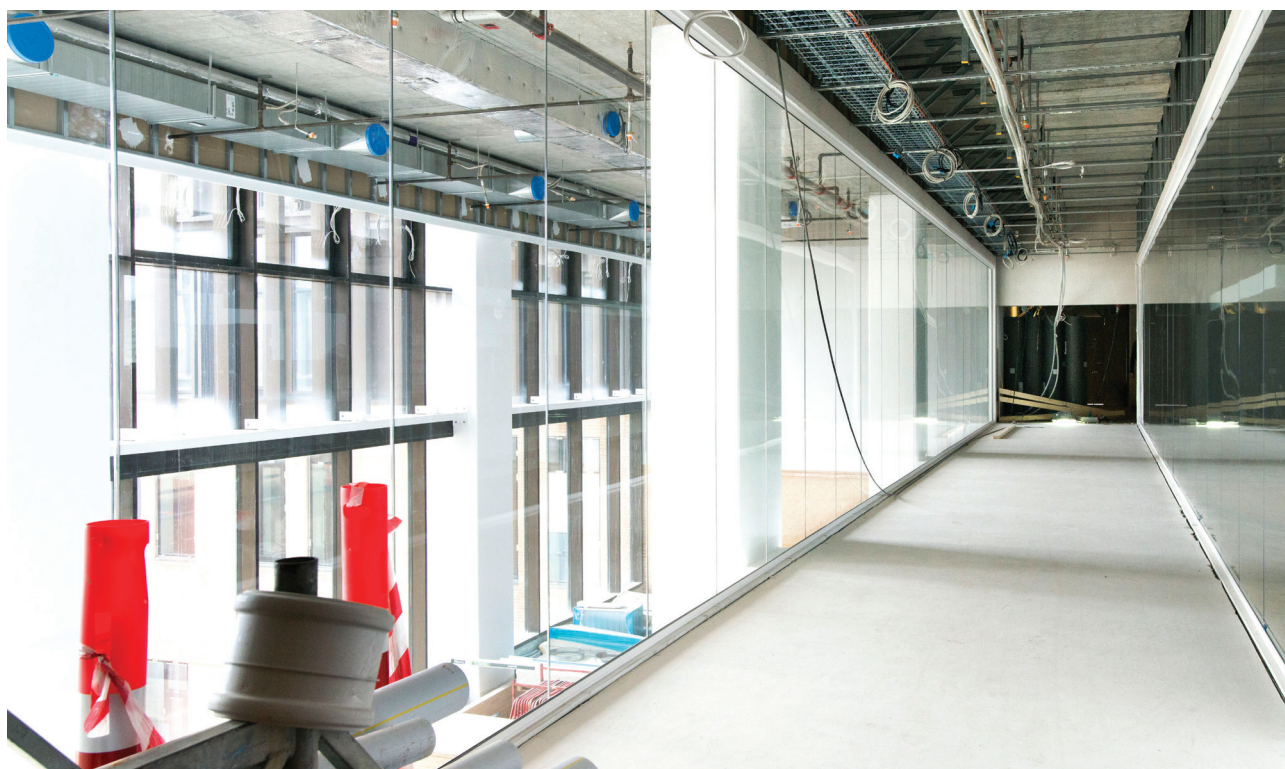
Forbindelsesvejen i det nye byggeri mellem fysiologisk afsnit og nuklearmedicinsk afsnit er næsten færdig.
